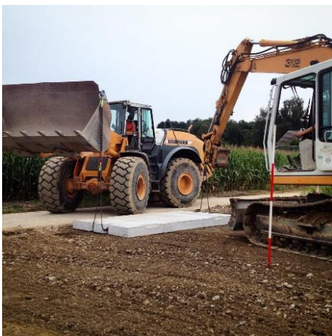
Bild 5: Einsetzen eines Betonverbundelementes
